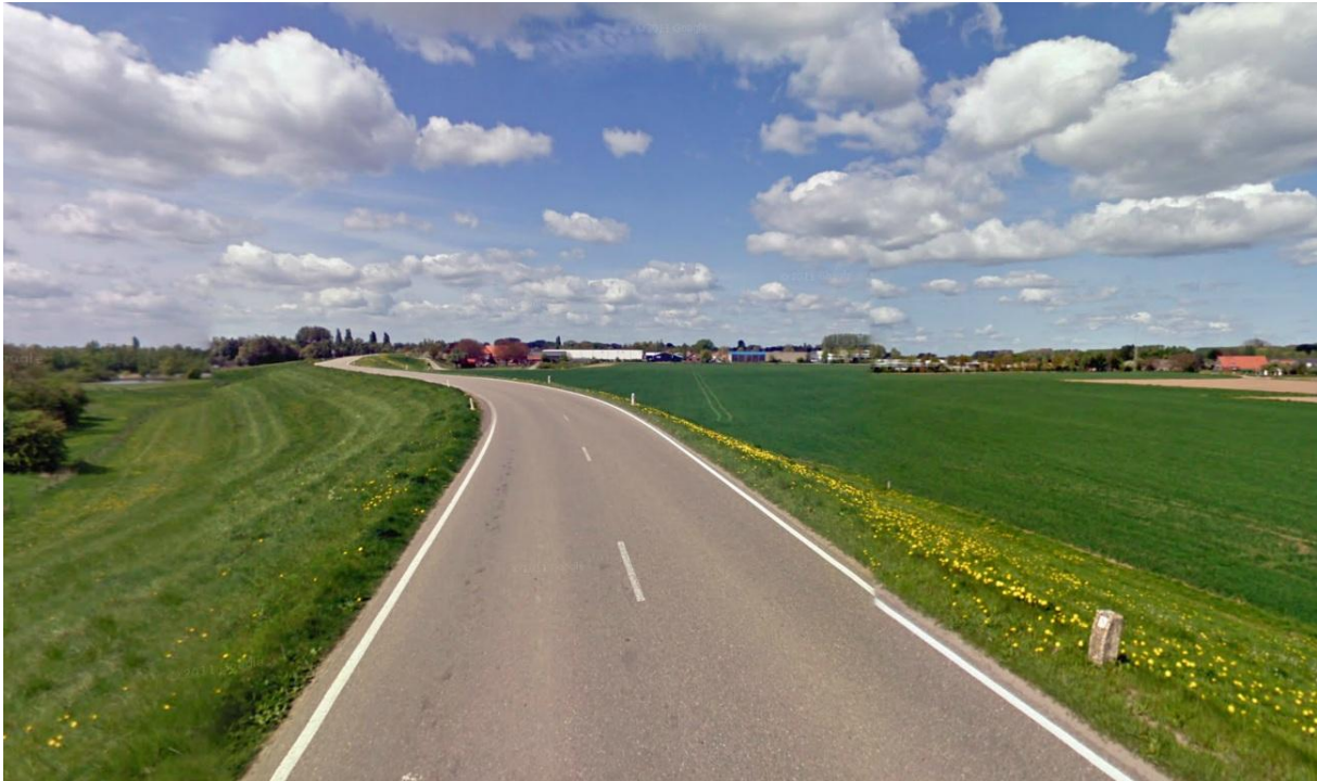
Figuur 4: wegbeeld Rijndijk - Pannerdense Dijk
